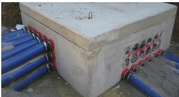
Připojení chráničky Hateflex pomocí systémových vík HSI 150 MA 168 GR.
