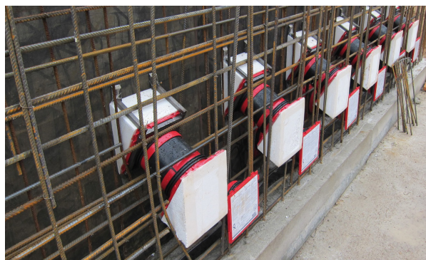
Šikmé ucpávky HSI 150 před betonáží
