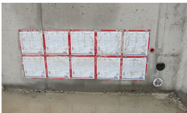
Ucpávka HSI 150 po zabetonování
