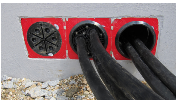
Kabely v systémovém víku HSI 150 DG 3x24-54
