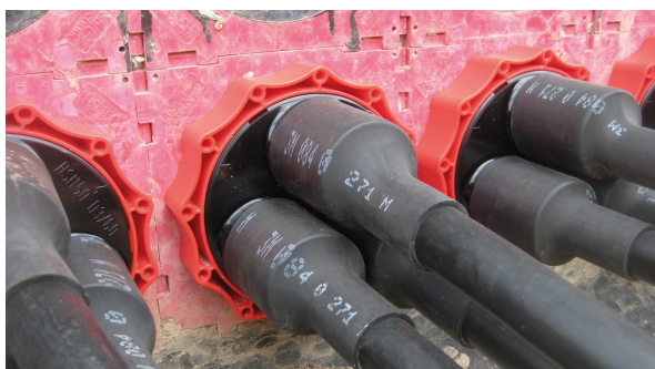
Kabely utěsněné ve víku HSI 150 D3x58 KS
