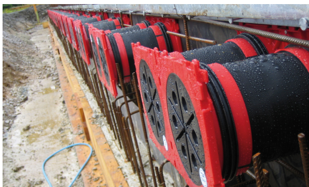
Dvojitá ucpávka HSI 150 před betonáží
