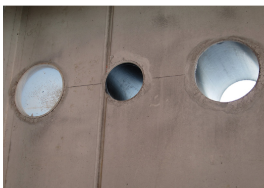
Pažnice HRD FU po betonáži
